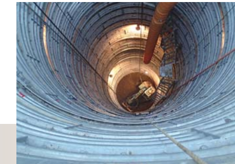
平成26年度 長野南二期地区集水井1工事
