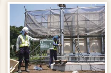
焼津市総合体育館 さく井工事
