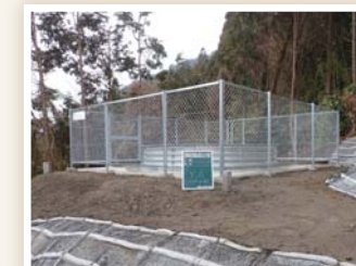
平成26年度 長野南二期地区集水井1工事
