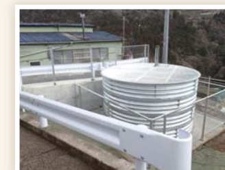
平成27年度 治山(地すべり)崩野工事
