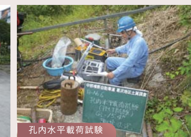
孔内水平荷重試験
